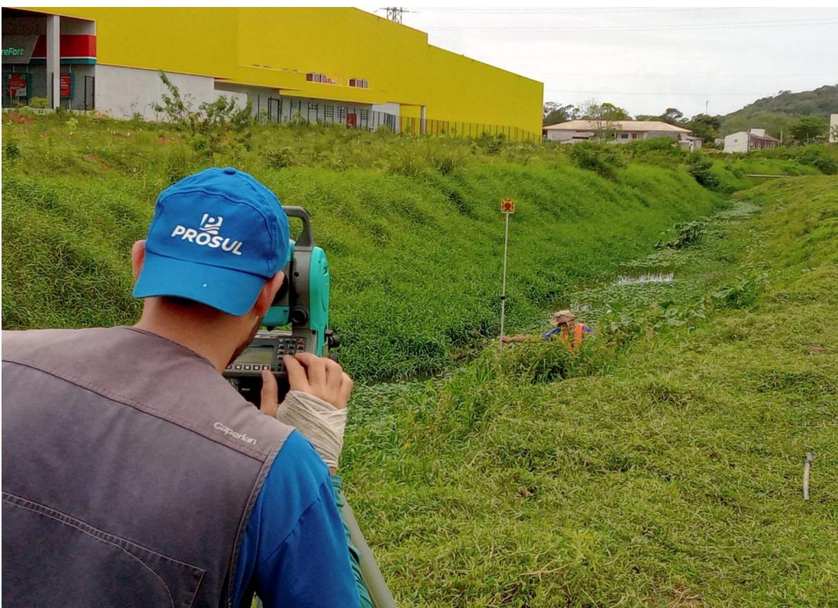
**Figura 3.10 – Levantamento Planialtimétrico e Cadastral**
