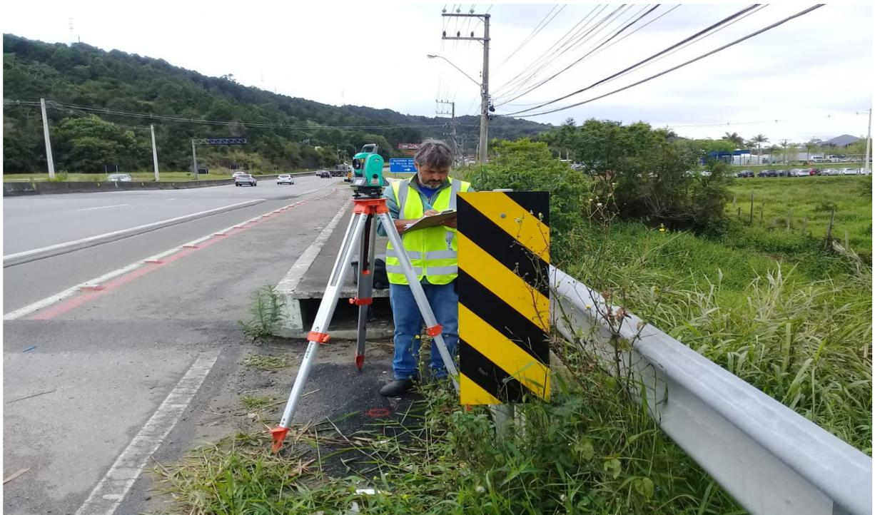
Figura 3.8 – Levantamento Planialtimétrico e Cadastral
